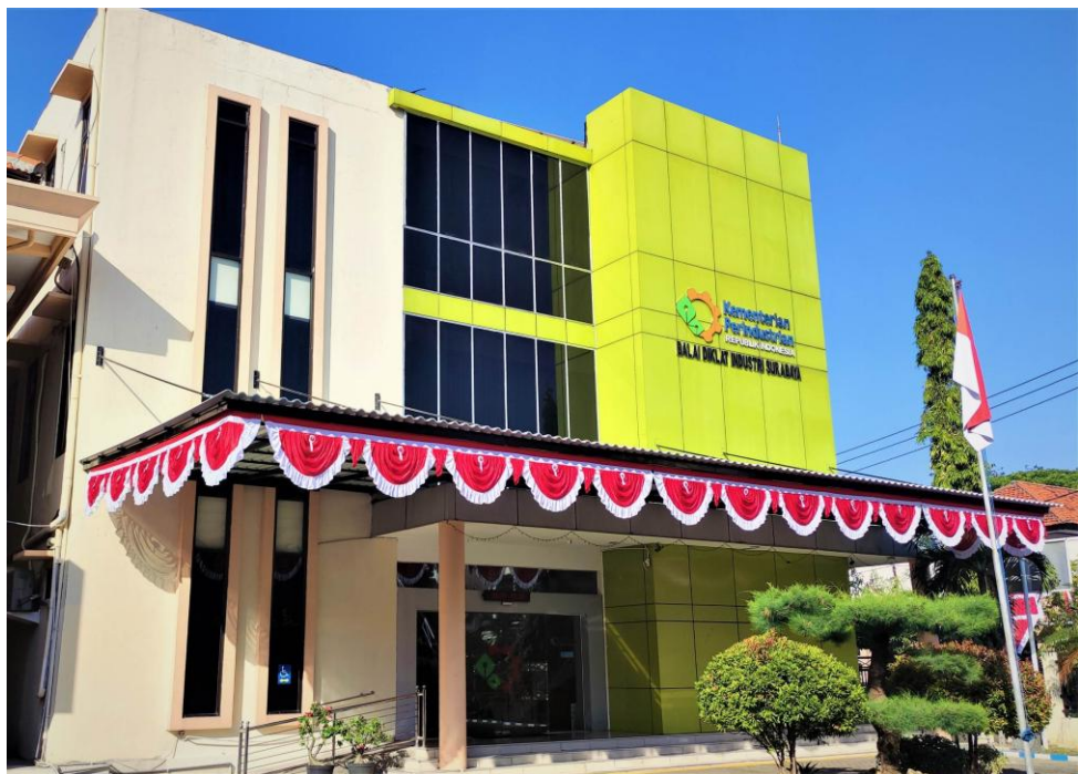
Gedung Kantor Balai Diklat Industri Surabaya
